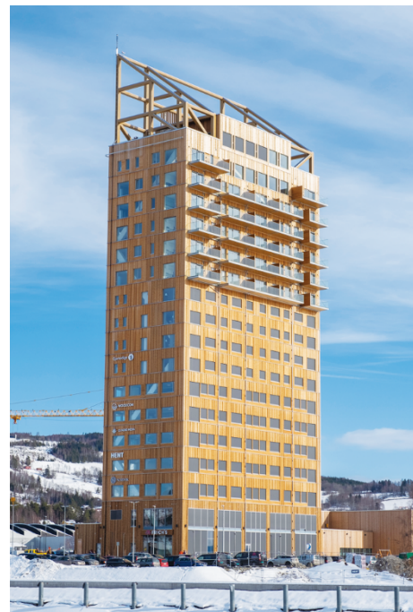
图1. 米约萨塔这座位于挪威的18层建筑的大部分强度均来自工程木材,这些木材构成了其所有的梁、柱和桁架。支撑其地板的木梁最厚可达720 mm,建筑物四角的柱子最厚达1425 mm。来源:Wikimedia Commons (CC BY-SA 4.0)。
