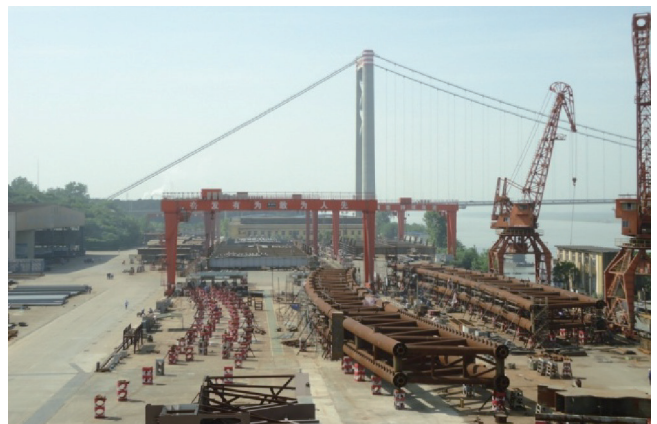
图9. 拱桁吊段卧拼耦合制作。
