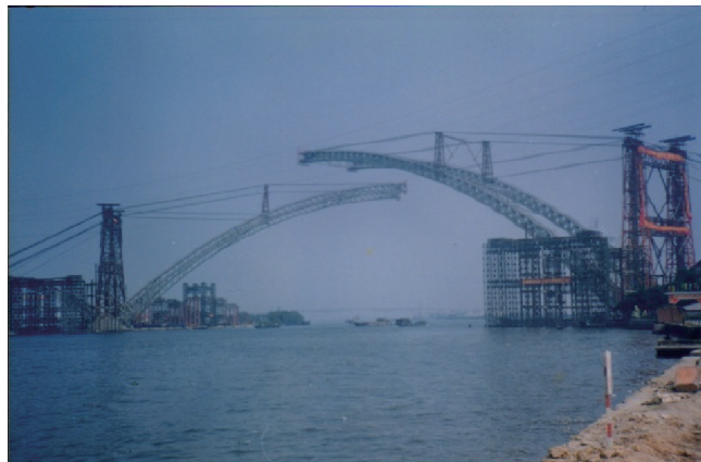
图6. 广州丫髻沙大桥转体。
