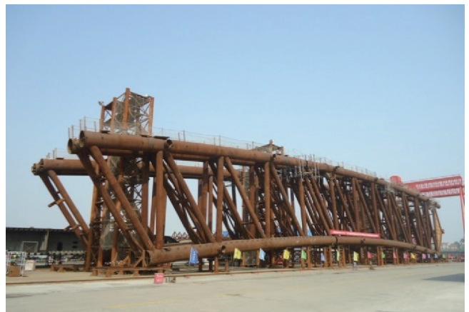
图8. 拱桁吊段立拼耦合校验。
