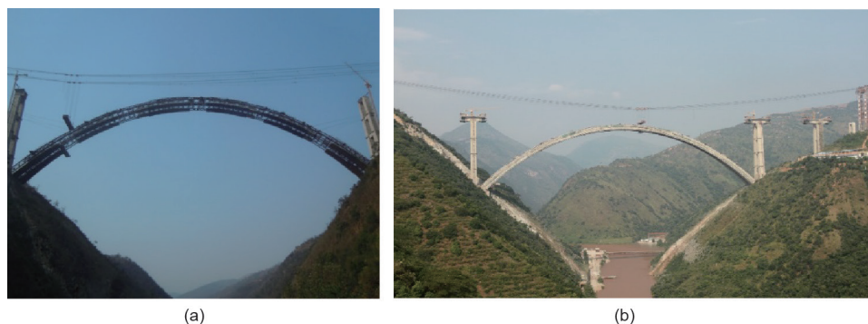
图15. 南盘江特大桥劲性骨架及混凝土拱圈。
