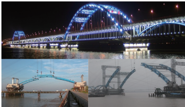
图5. 杭州复兴大桥斜拉扣挂悬拼。
