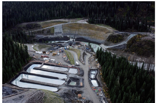
图6. ULR与上游洞口/取水口处的施工用水管理设施。
