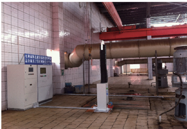
图9. 6.5 \times 10^4 \text{ t} \cdot \text{a}^{-1} 电解锰陈化液胶体化过程中 \text{Fe}^{3+} 浓度智能化在线实时监测设备。
