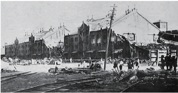
图5. 1923年关东大地震中损坏的砌体结构建筑[5]。
