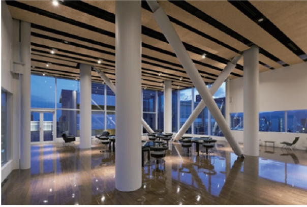
图17. 使用BRBs的被动控制建筑（日本京都外国语大学）。
