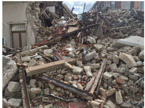
图3. 2016年阿玛特里切地震中倒塌的砌体结构建筑。
