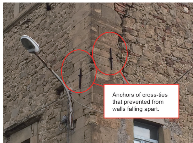
图4. 阿玛特里切地震中幸存的交叉加固砌体结构建筑。
