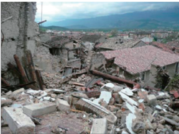
图2. 2009年拉奎拉地震中倒塌的砌体结构建筑[4]。
