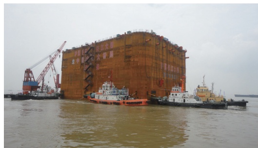
图 2 钢沉井出坞浮运
