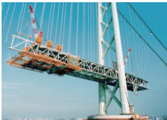
图 10 架梁吊机桁片安装
