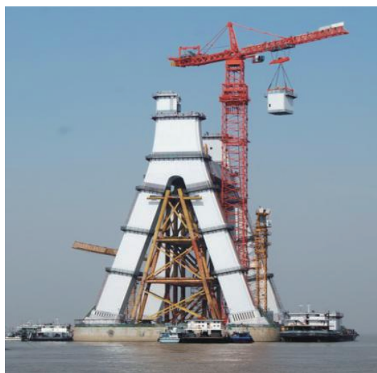
图6 塔吊安装钢塔节段
