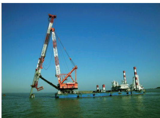
图5 打桩船插打钢桩
