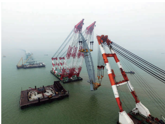
图7 浮吊安装钢塔节段
