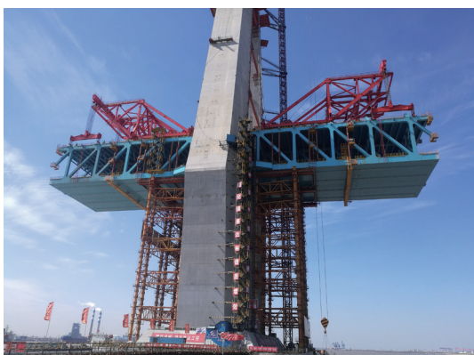
图8 沪通长江大桥双节段钢梁架设
