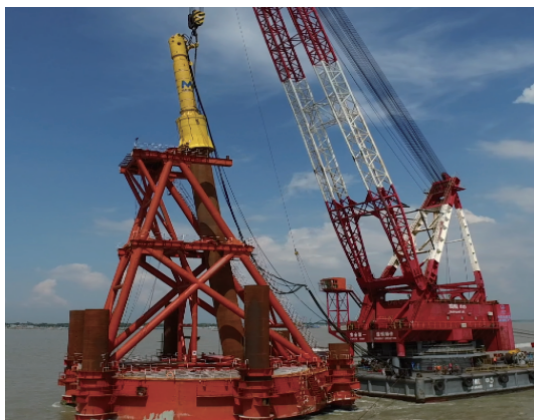
图4 固定导向架插打钢桩
