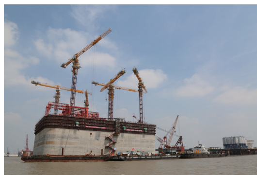
图 3 上部混凝土沉井接高
