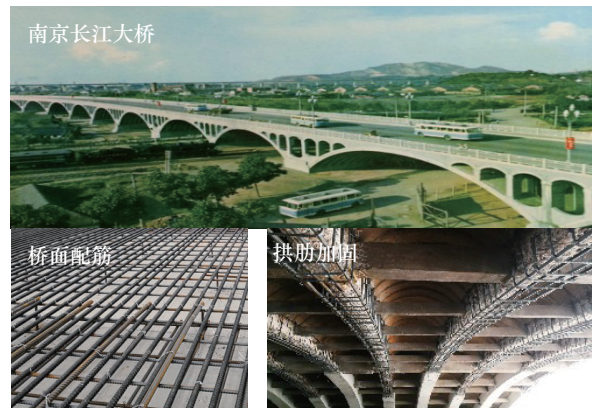
图 5 BFRP 网格 / 筋加固南京长江大桥桥面及拱肋
