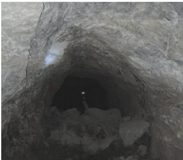
图1. 白音诺尔铅锌矿巷道顶板岩石弹射。
