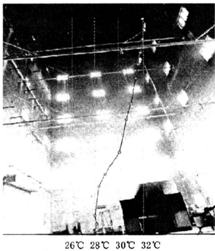
图 7 大空间实验厅内部概貌及垂向平均温度
