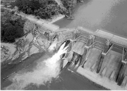
注:全长700 m,在断层通过处坝体垮塌,断裂处南侧拱起约9.8 m,北侧拱起约2 m,但坝体未垮
