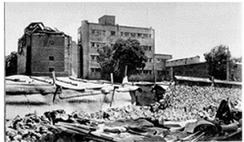
注:为现浇钢筋混凝土框架结构的五层楼,其左配楼,因位于强震发生断层上而倒塌
