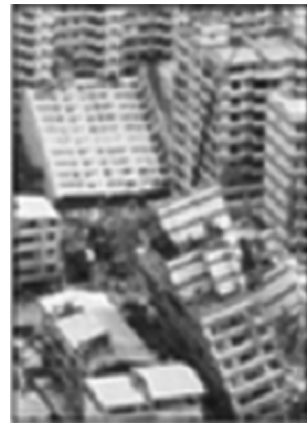
注:断层内受地震的影响高楼如骨牌倾倒而其旁断层外的高楼仍耸立,破坏轻微
