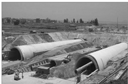
图7 翔安端洞口全景
