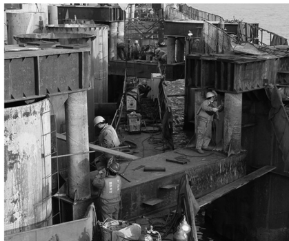
图6 竖向定位结构
