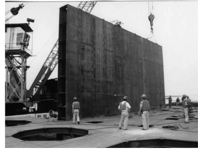
图3 钢吊箱现场拼装
