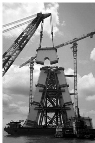
图6 中塔 D4 节段吊装
