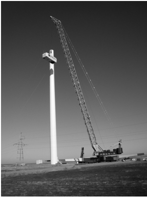
图 12 样机现场吊装机舱
