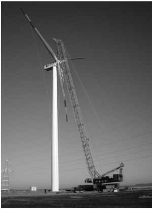
图 13 样机现场吊装叶片
