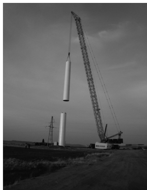
图11 样机现场吊装塔筒
