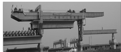
图10 制式 TLJ900 型架桥机
