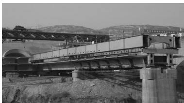
图 13 移动支架隧道口造梁
