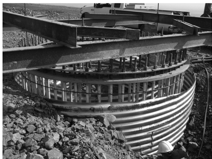
图4 在施工的P-H基础 Fig.4 Construction of P-H foundation 注: 源自 RES - Americas
