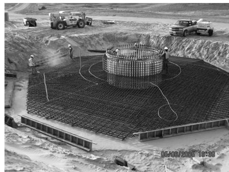
图2 重力式基础施工 Fig.2 Construction of gravity foundation 注: 源自 RES Americas
