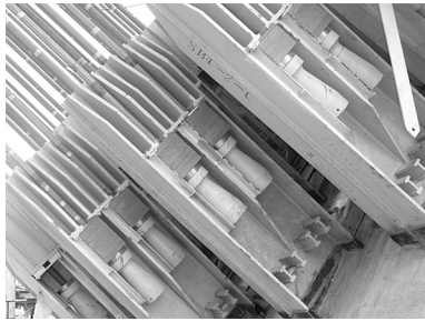
图6 主缆锚固钢板形式锚固系统
