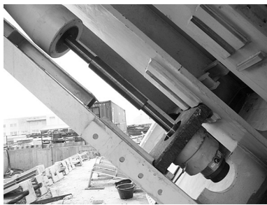
图7 套接式千斤顶张拉拉杆系统
