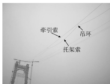
图7 吊环法架设托架索
