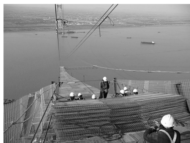
图 11 猫道面层单元塔顶分段组拼下放
