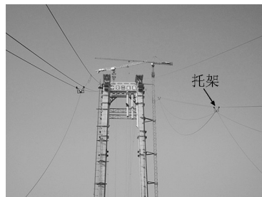
图8 托架法架设猫道索
