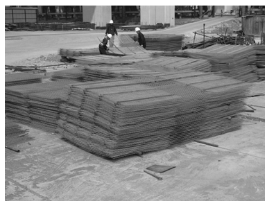
图 10 猫道面层后场拼装成单元
