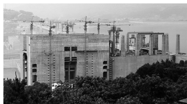
图1 施工形象进度图
