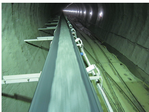
图5 TBM掘进长距离皮带出碴
