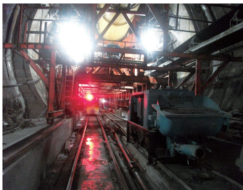
图6 TBM掘进同步衬砌
