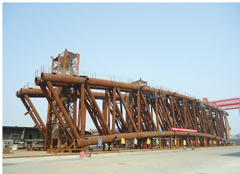
图2 拱桁立式拼装
