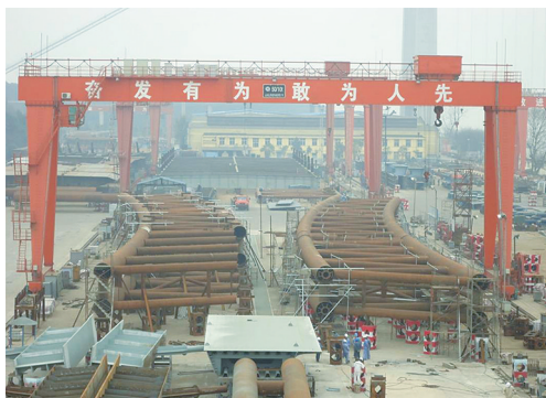
图3 拱桁卧式拼装
