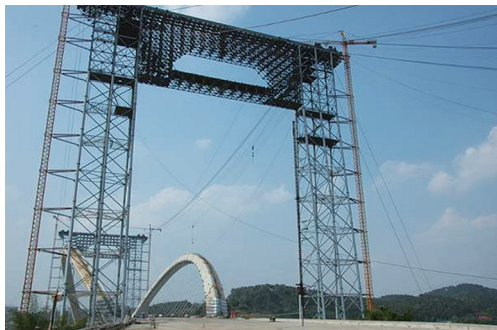
图5 南宁大桥“吊扣合一”塔架
