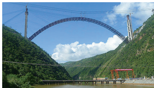
图4 云桂铁路南盘江特大桥的钢管混凝土劲性骨架
