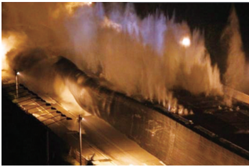
图3 3.5 km 沌阳高架桥起爆瞬间
