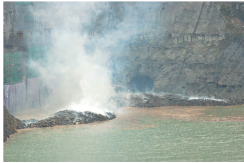
图4 柘溪水电站进水口挡水岩坎爆破
