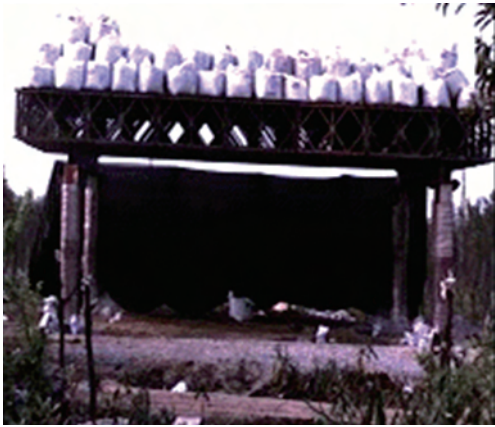
图2 3.5 km 沌阳高架桥物理模型试验
