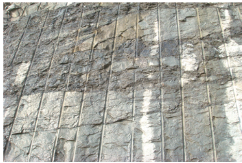
图5 向家坝水电站右坝肩精细爆破开挖效果
