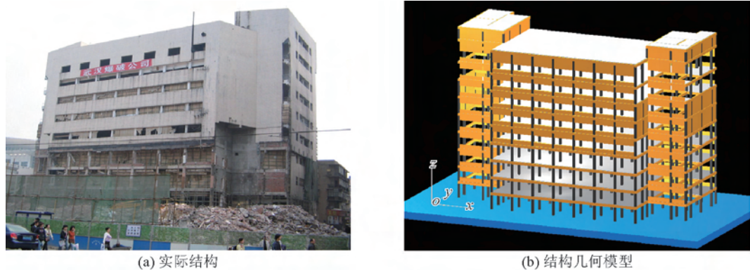
图8 拆除爆破前实际结构与结构的几何模型
