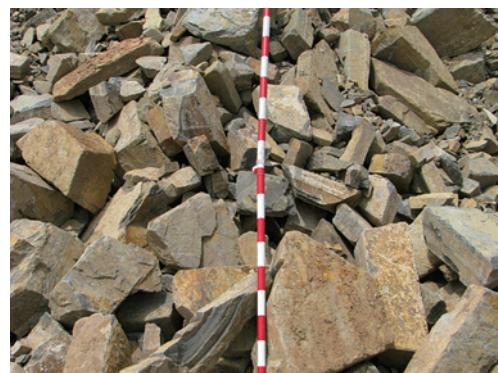
图6 连续装药结构爆后效果
