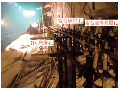
图 3 Ⅲ5 区岩台开挖竖向孔钻孔样架搭设
