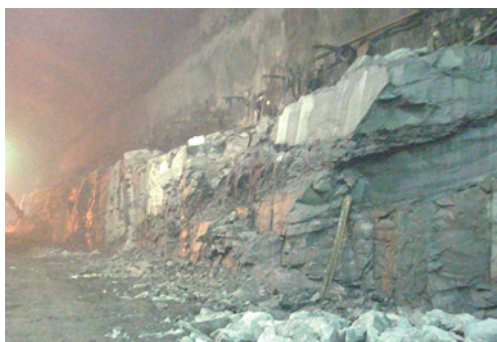
图1 地下厂房岩壁梁部位工程地质条件
