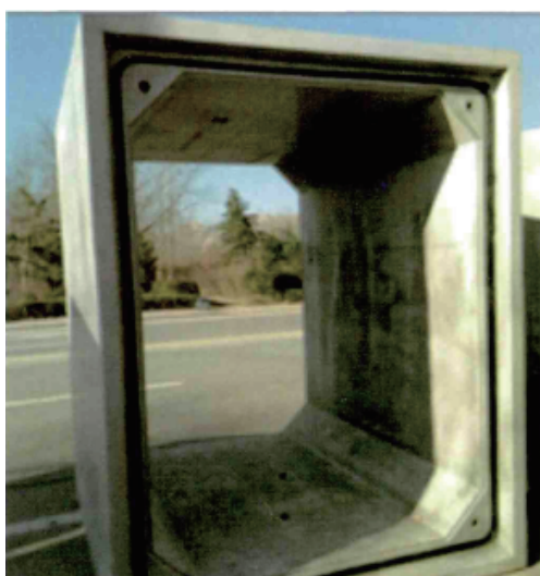
图3 预制混凝土箱涵
