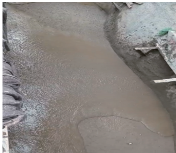
图 16 预拌固化土回填
