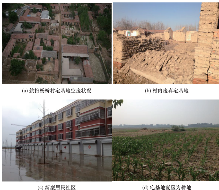
图1 杨桥社区空心村综合整治工程
