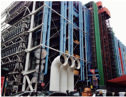
图11. 1977年由Renzo Piano和Richard Rogers建设的蓬比杜中心。所有的建筑物结构和机械系统都暴露在外面，成为建筑物立面美学的组成部分。(图片提供：DOSU建筑公司)
