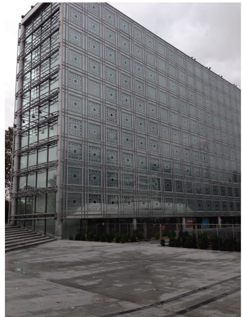
图14. 位于巴黎的阿拉伯世界博物馆的建筑物立面可以跟随阳光移动。(图片提供：DOSU建筑公司)
