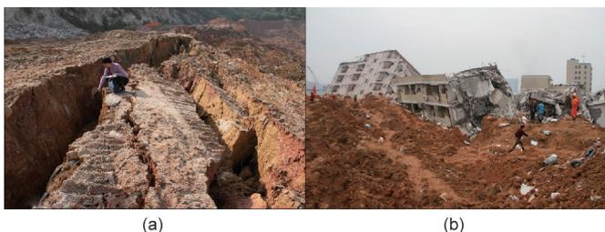
图6. 滑坡发生两天后拍摄的照片。(a)滑坡后缘残余的不稳定堆填体；(b)前部被损毁的建筑物和含水率很高的流态化堆积体。
