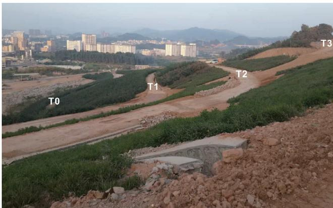
图3. 2015年10月10日深圳“12·20”滑坡发生前渣土场前缘工程边坡和台阶照片,地表排水设施已建立完成。
