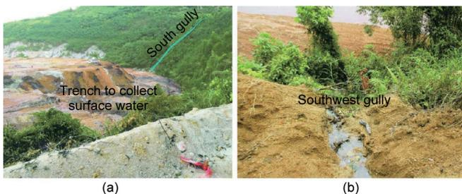
图16. 降雨和长期入渗在后缘冲沟形成地表径流且持续入渗到渣土场后部堆填体中。(a)南侧冲沟及排水沟，摄于2015年11月24日；(b)西南侧冲沟中常年径流，摄于2015年12月21日。
