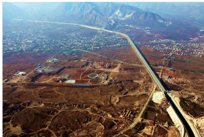
图3. 南水北调中线工程漕河渡槽。
