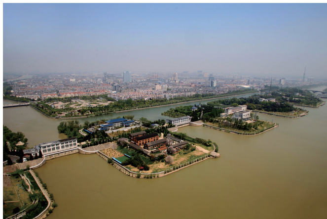
图2. 南水北调东线工程江都泵站。
