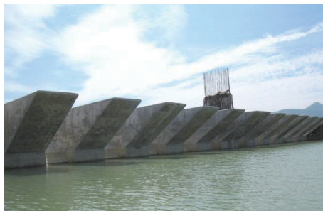
Fig. 3. The Van Phong PK Weir in Vietnam.
