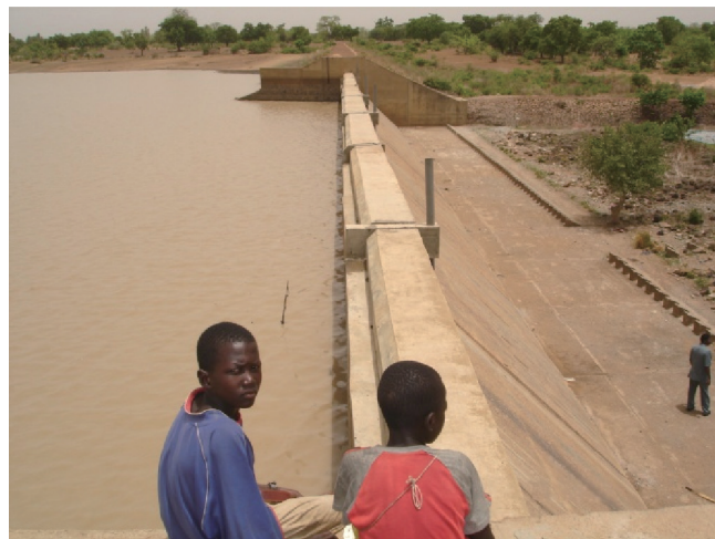
图5. 小型水坝的混凝土应急自溃坝段：Burkina Faso的Webila水坝。
