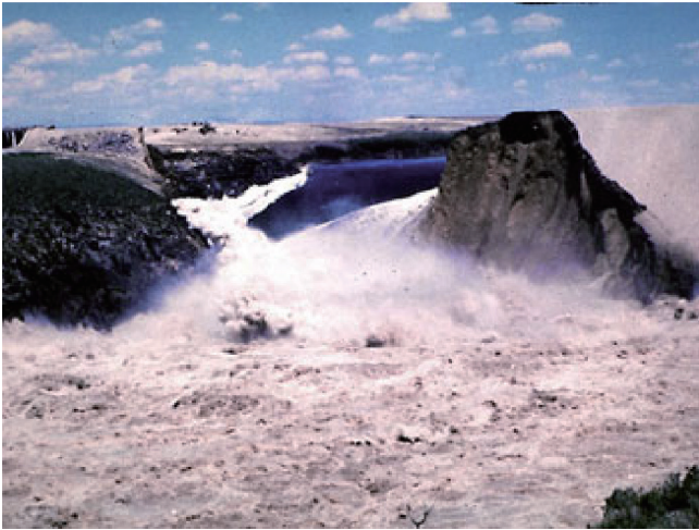
图9. Teton 大坝溃塌。
