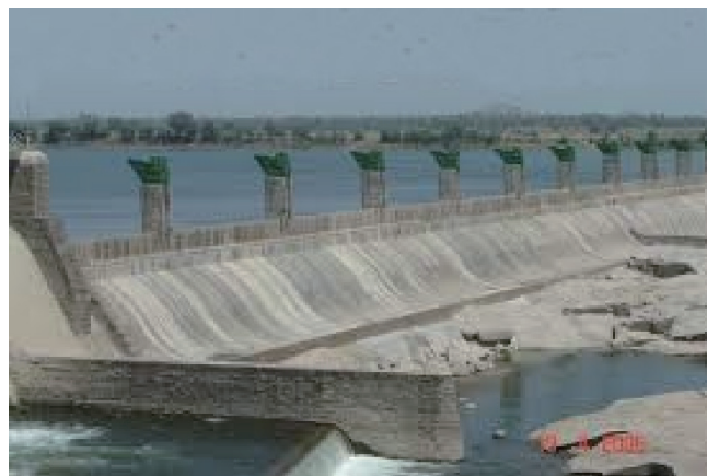
图6. 洪水溢出Wanak Bori大坝的自溃闸门。
