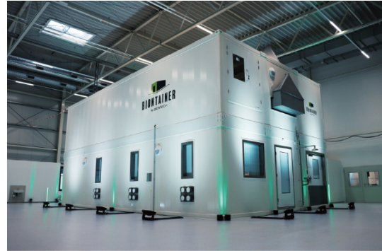
图1. BioNTech的模块化工厂由原料药模块和配方模块构成，用于生产与辉瑞合作研发的mRNA疫苗。这种工厂被称为BioNTainer，其设计年产量可达5000万剂，并且建设成本远低于传统的工厂。来源：BioNTech（公有领域）。
