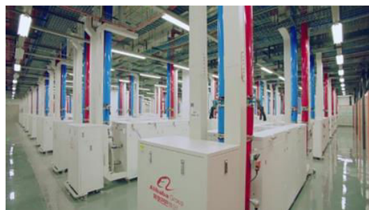
图8 阿里云浸没式液冷服务器
