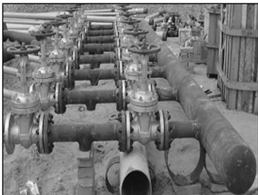
图3 总机关预制模块
