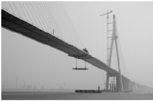
图 12 中跨合龙段吊装
