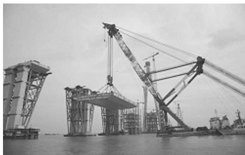
图 10 边跨大块梁段安装
