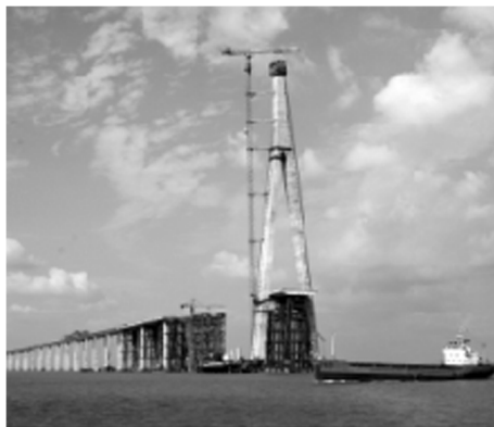
图6 施工中的索塔 Fig. 6 Pylon under construction
