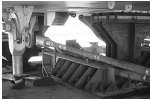
图 11 塔梁临时固接
