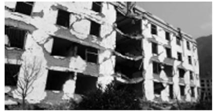
图11 间隔设置构造柱的砌体结构震害(非本院设计)
