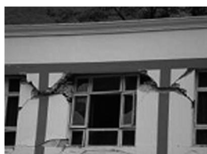
图10 由竖向地震作用导致顶层窗间墙发生水平裂缝(非本院设计)
