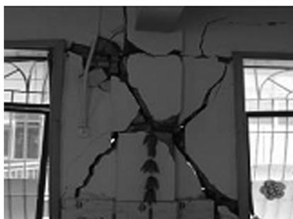
图9 由平面外弯矩及面内剪力引起的窗间墙水平裂缝及X形裂缝(非本院设计)
