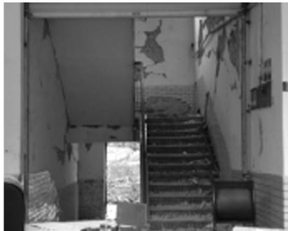
图 7 龙门山镇教学端部楼楼梯间墙裂缝图
