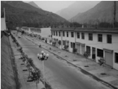
图2 东风新村居民建筑物在汶川地震中丝毫无损
