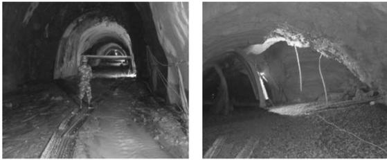
图4 突水突泥淤积 I 线正洞及破坏双层初支
