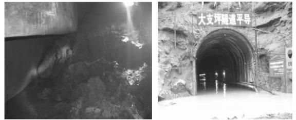
图3 平导 PDK132 + 990 突水突泥
