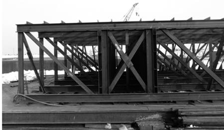
图5 各单元件精确拼装
