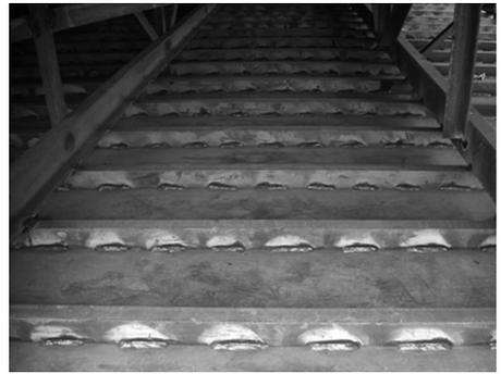
图10 角焊缝焊接实景图
