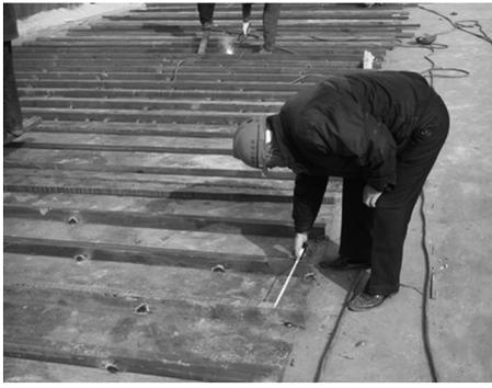
图7 外壁单元件尺寸控制
