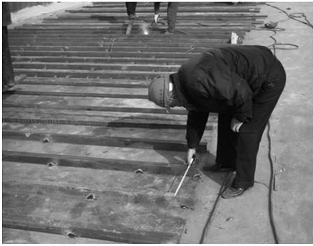
图7 外壁单元件尺寸控制
