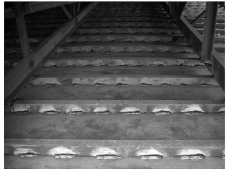
图10 角焊缝焊接实景图
