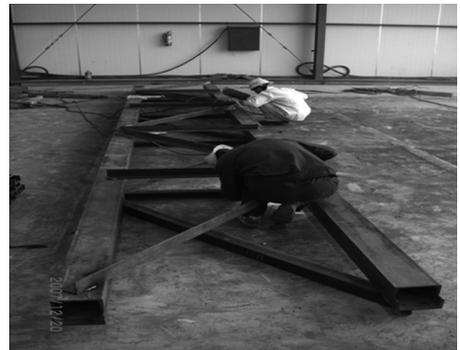
图6 桁架单元定位焊接
