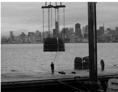
图10 起吊过程 Fig. 10 Lift process
