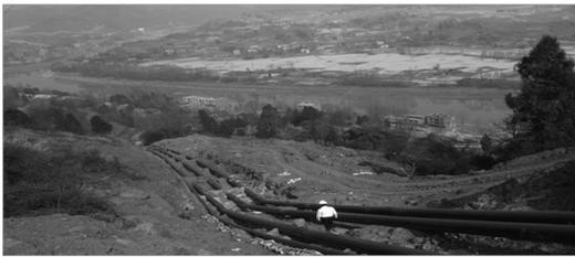
图 4 多管输送现场布置图
