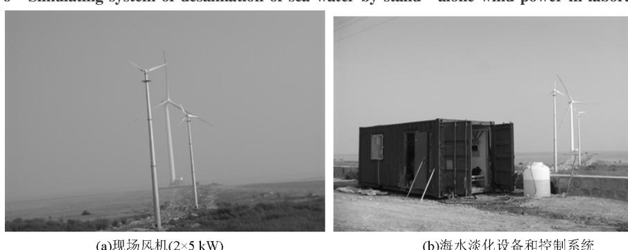
图 7 独立风电 - 海水淡化系统现场示范运行
