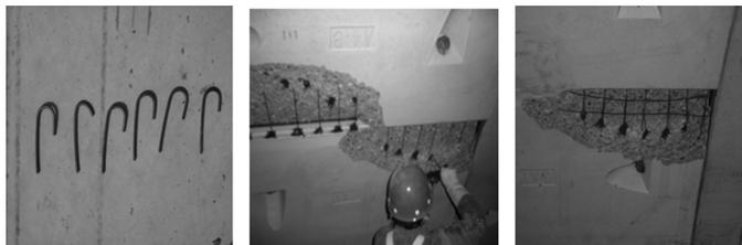
图 7 植筋作业流程图
