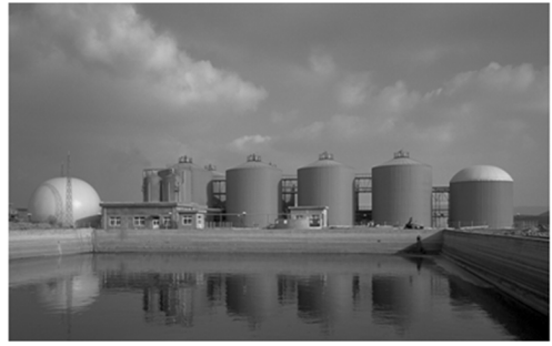
图6 山东民和牧业3 MW沼气发电厂(日产沼气30000 m 3 )
