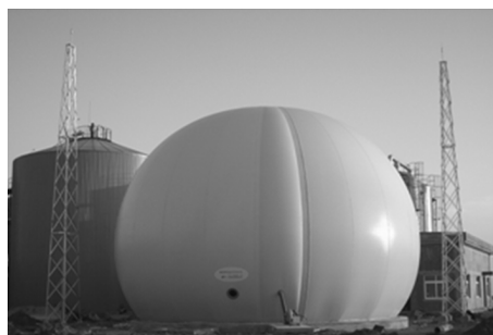
图 4 低压双膜干式贮气柜
