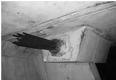
图1 凸块锚固区
