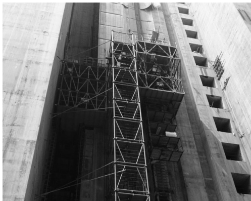
图1 卷扬提升升降平台 Fig.1 Hoist lifting platform
