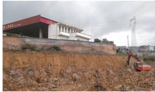
(b) 加油站附近泥夹层采用机械破碎
