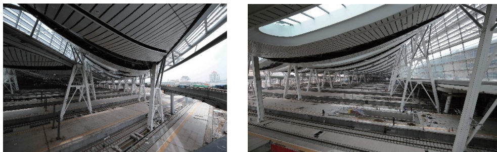
图 3 施工过程中的北京南站
