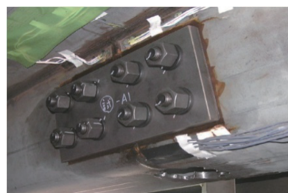
(a) 钢板+高强螺栓加固
