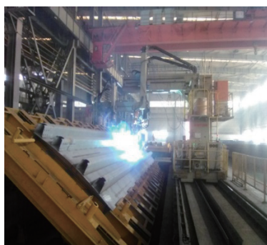
(b) 钢桥面板焊接机器人
